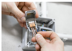
Aangesloten klem in de gelbox plaatsen.
